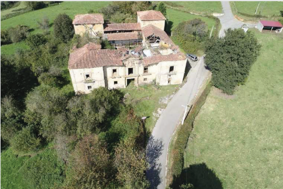
Imagen 6. Vista aérea del Palacio de la Torre de Celles desde el sur, con edificaciones existentes en la esquina superior derecha en un estado previo a las labores de limpieza (Fotografía aportada por el promotor).
