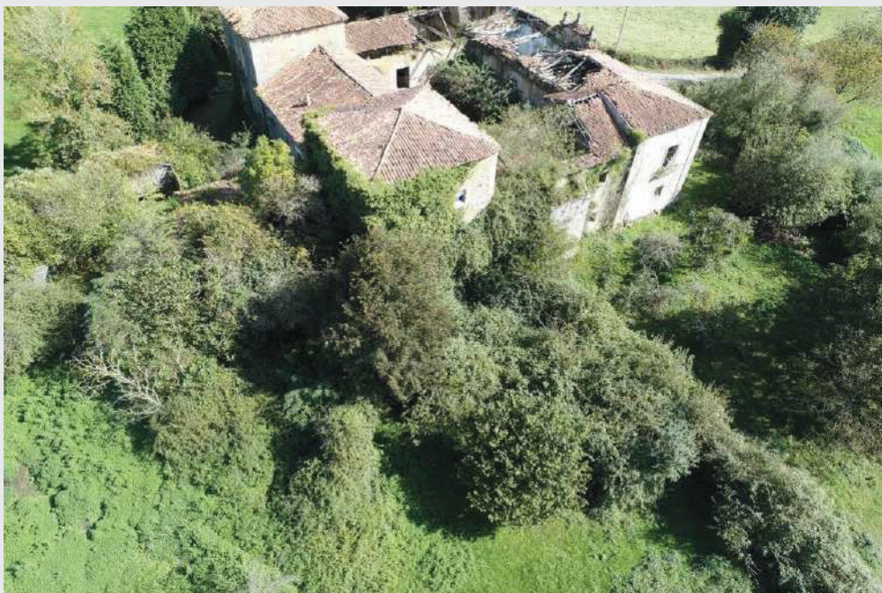
Imagen 8. Vista de la panera y de la capilla ocultas por la vegetación preexistente al comienzo de las actuaciones de desescombro y limpieza (fotografía aportada por el promotor).
