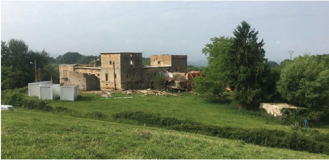
Figura 1.4.3.6.2 Fotografía a mayo de 2023, durante los trabajos de Limpieza y conservación
