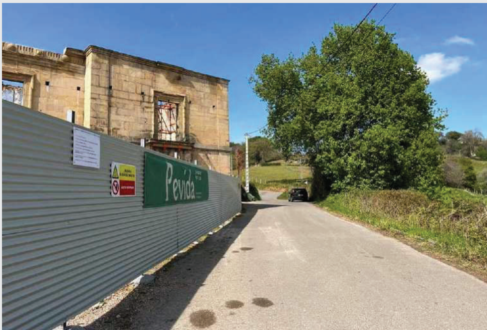
Imagen 9. Vallado perimetral condicionando el acceso al Palacio de la Torre de Celles desde el vial adosado al conjunto edificatorio (vista hacia el norte).
