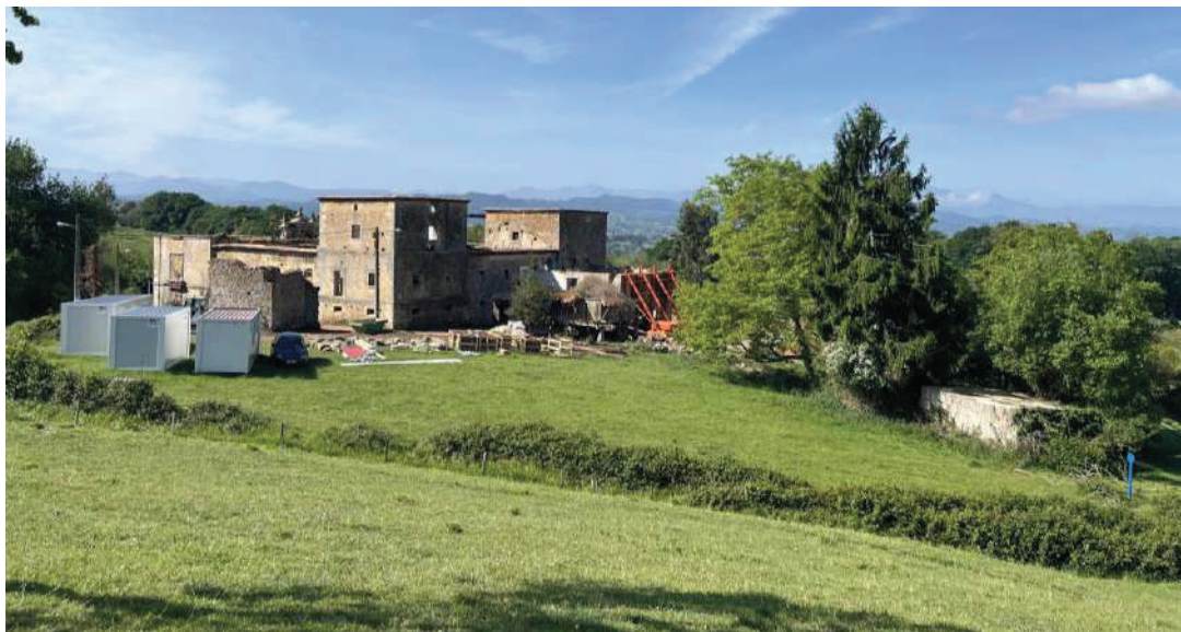
Figura 1.5.3.4 Construcciones auxiliares: Panera, restos de capilla y tendedjón
