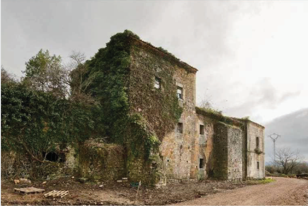
Imagen 3. Fachada oeste del BIC con presencia de un apoyo de la línea de media tensión próxima al mismo (fotografía aportada por el promotor).
